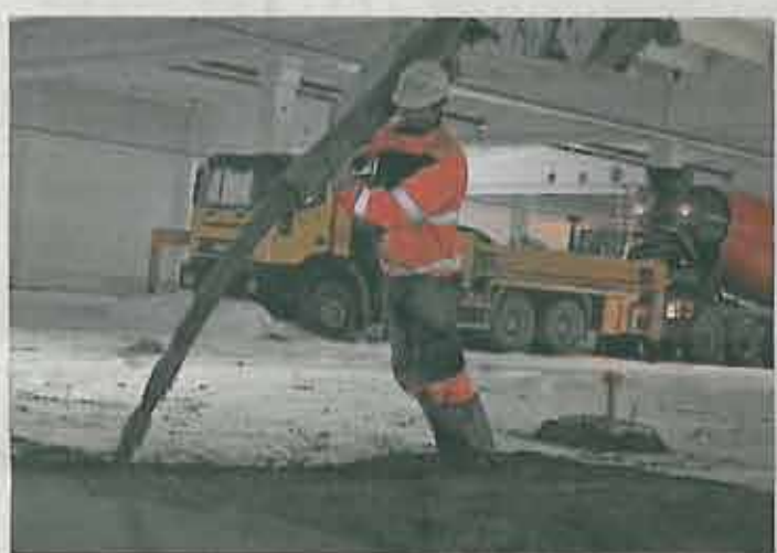
Jari-Pekka Lintulahti valutti kuitubetonin uuden kauppakeskuksen lattioksi.
